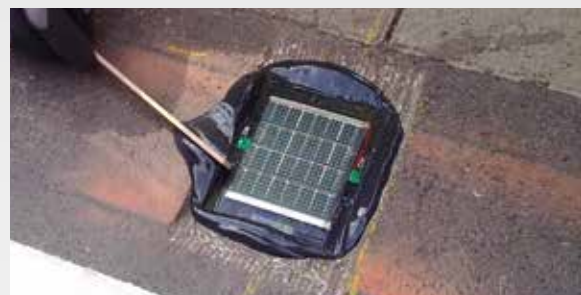
LED-Mark nedfræst i fodgængerovergang og limet
