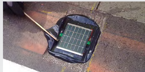
LED-Mark auf dem Straßenbelag montiert
